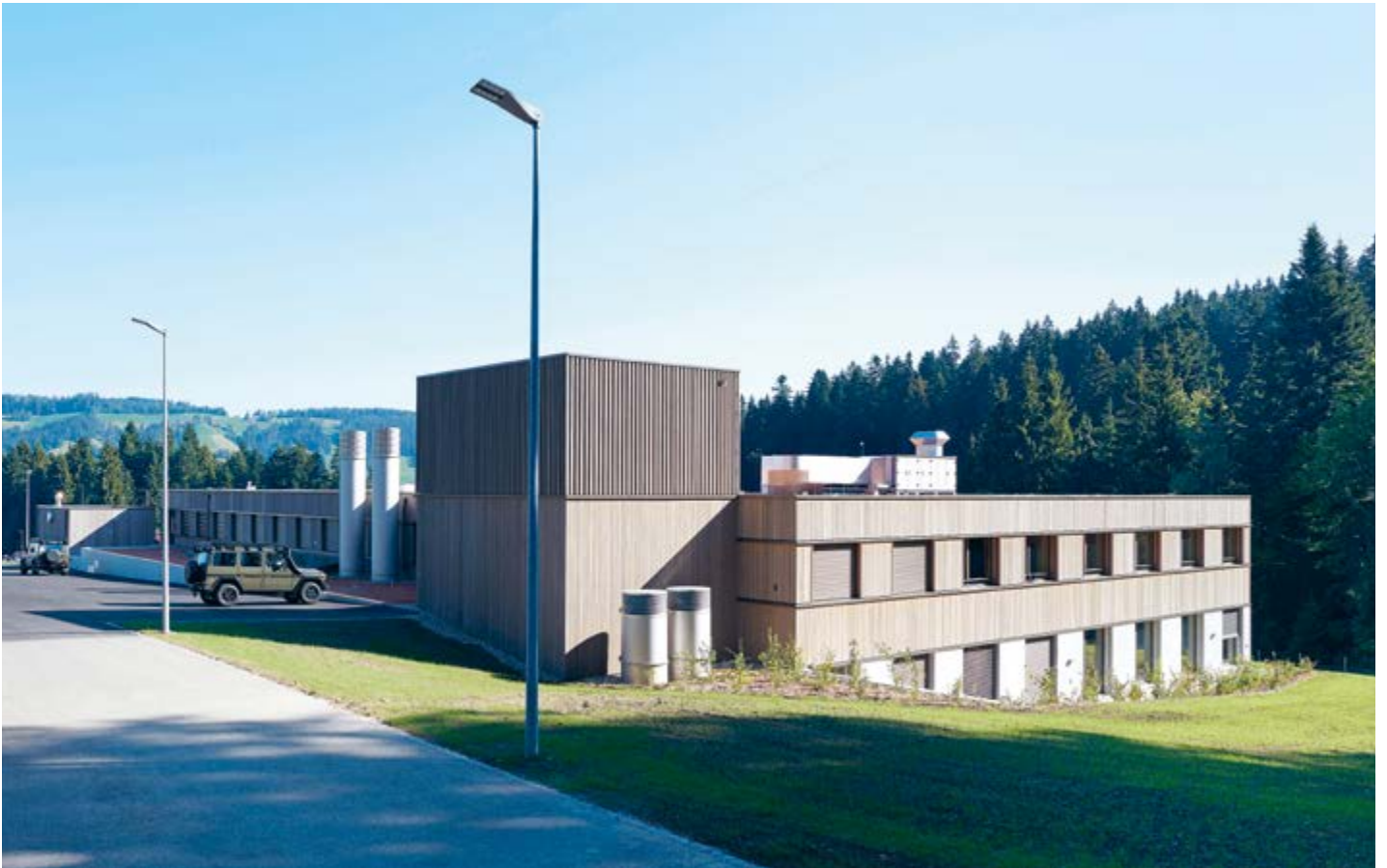
Nachhaltig, energiefreundlich und lokal: Für die Kaserne Jassbach wurde eine Gebäudehülle aus Schweizer Holz verwendet. Gebaut wurde sie nach Minergie-P-ECO-Standard.
